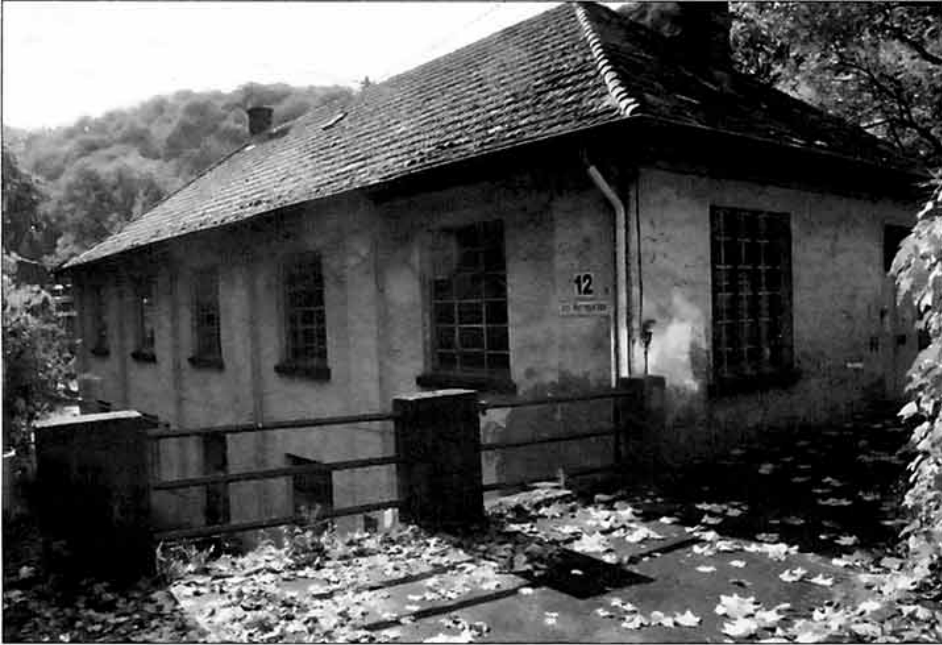
Die Reinhard & Sonja Ernst-Stiftung will das ehemalige Fabrikgebäude in der Nähe des Bahnhofs zur Musikschule umbauen. Fotos: Beate Palmert-Adorff
