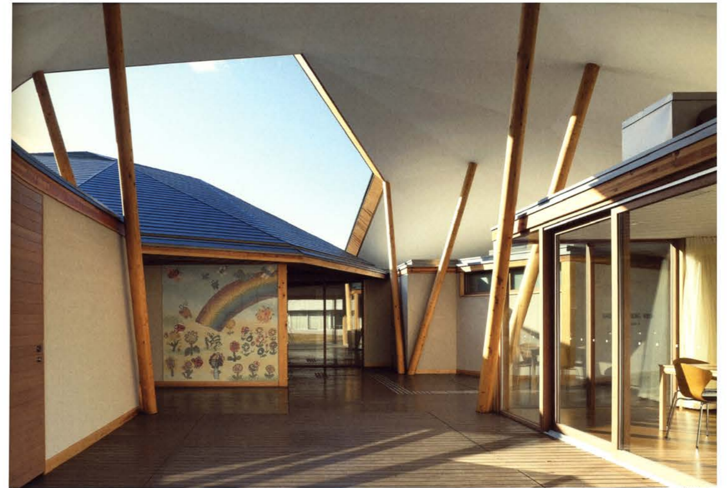
エントランス。大屋根の下、相談室や倉庫に挟まれた半屋外の空間。エントランス脇の壁画は、名取市立関上小学の1年生によって共同制作された絵を10mm角のモザイクタイルによって再現した。東側の外壁にはドイツの子どもたちによる壁画もある。
