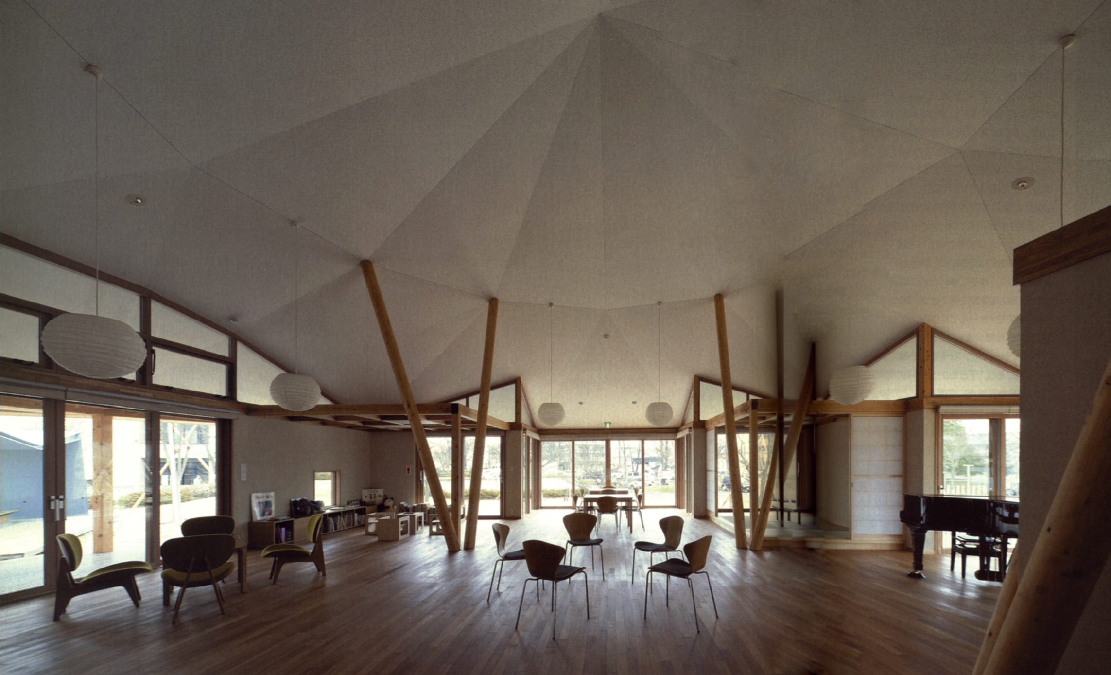
多目的室。頂部で約6,200mmの天井高さのドーム状の大屋根で覆われた空間で、軒高さは2,840mm。左手遊戯コーナーの子ども用の家具は藤江和子アトリエのデザインによるもの。家具やピアノは建物と共に名取市へ寄贈された。床はナラ複層材フローリング t=15mm。
