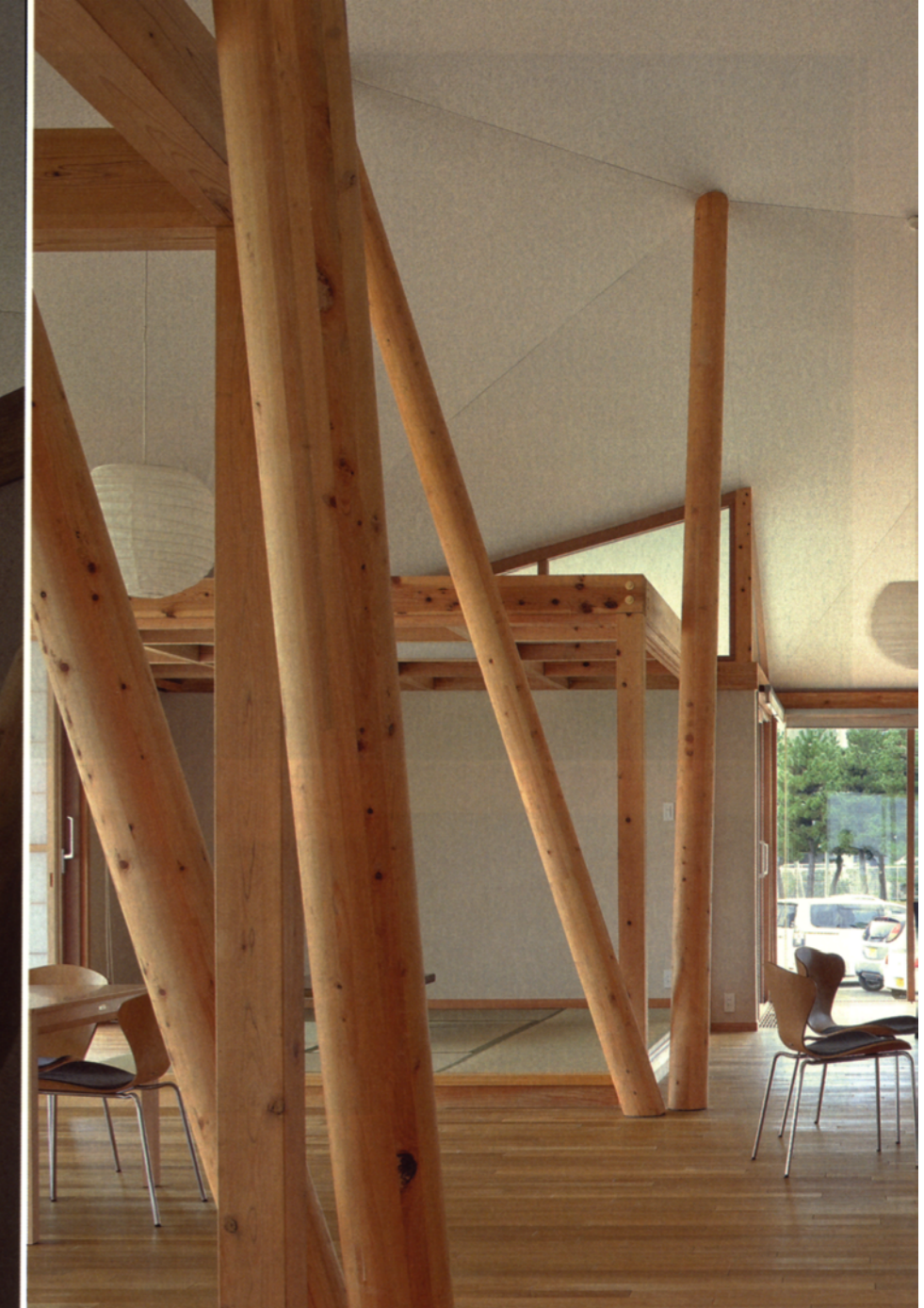
大屋根を支えるV字柱と水平力を受ける小屋。奥の小屋は畳コーナーとして障子で仕切ることができる。
