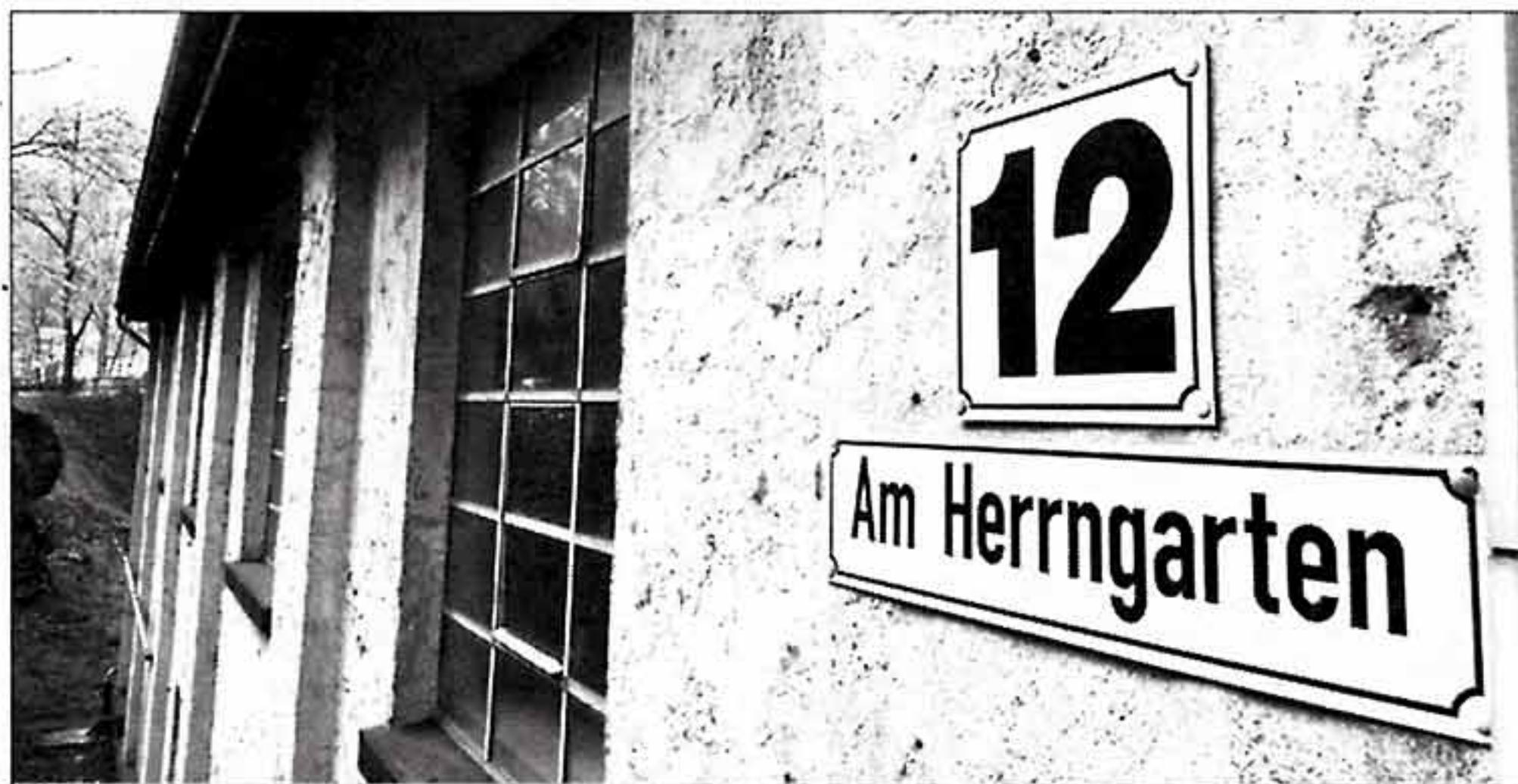
Das ehemalige Fabrikgebäude Am Herrngarten 12 wird vermutlich abgerissen.
