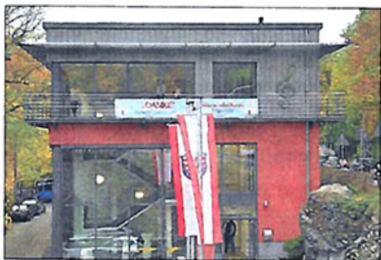
So sieht der Neubau „Am Herrngarten“ aus.
