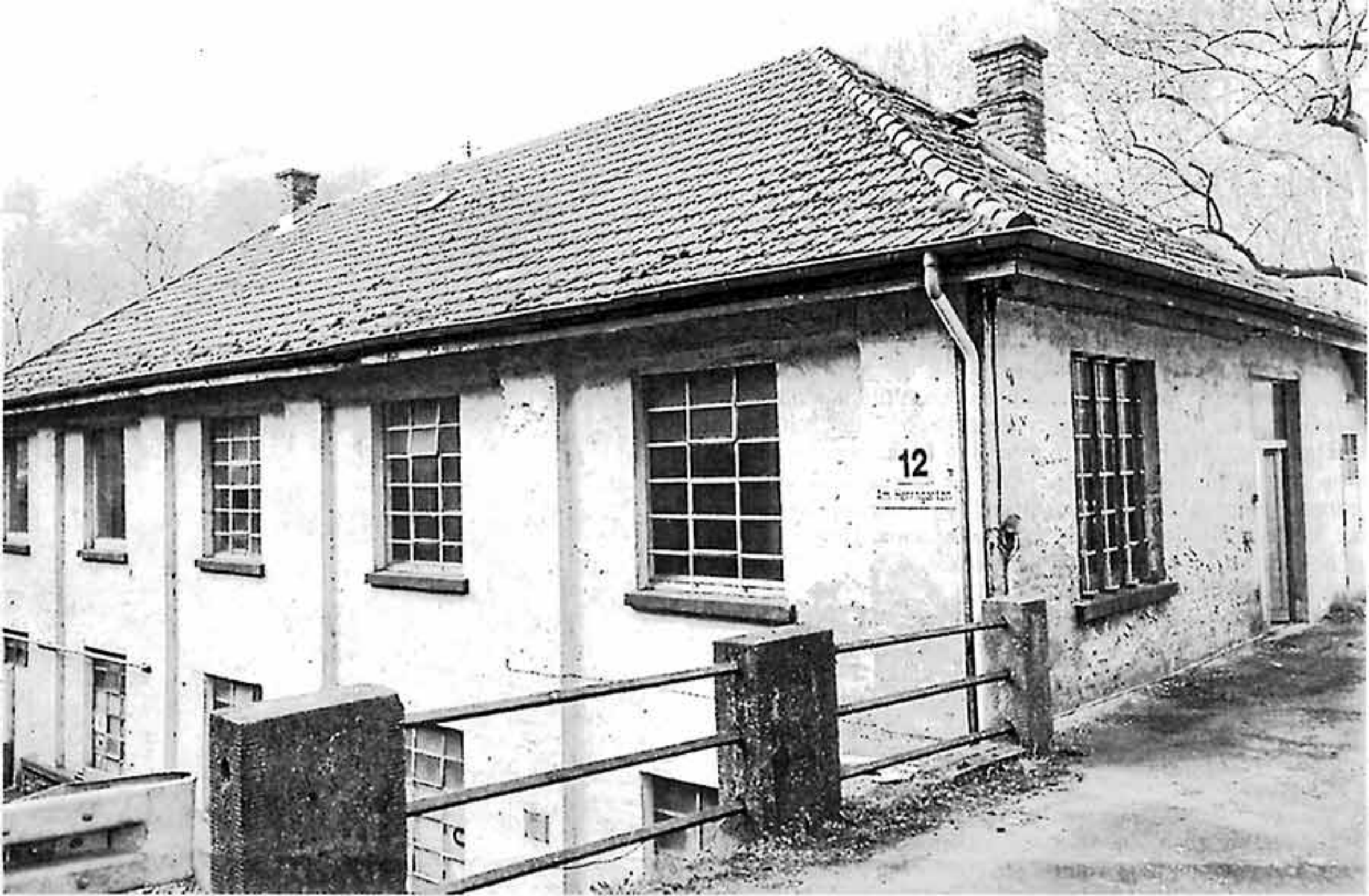
Das alte Gebäude im Herrengarten 12 muss dem Neubau einer Musikschule weichen.
