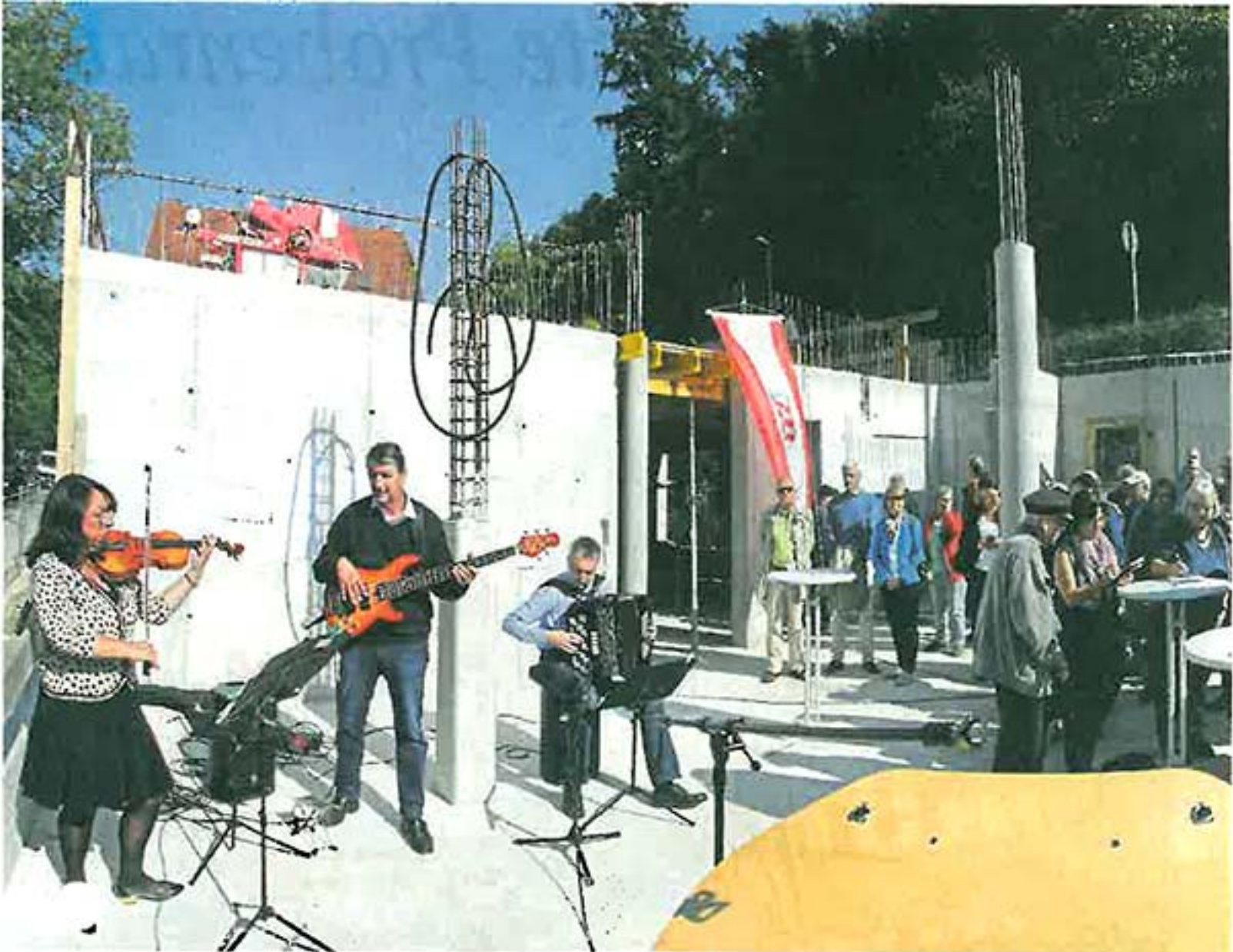
Baustellenbesichtigung mit musikalischer Untermalung.
